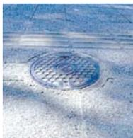
県庁楠並木通りにて排水口蓋の段差により転倒事故が発生し連絡を受け応急処置を施し最終的にレベルを合わせ完成。
