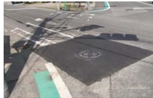
マンホールの段差及び噛み合わせ悪く、車が通る度に段差音が発生、行政に改善要望し早急に対応していただき完成。
