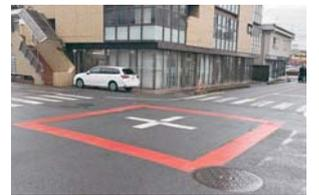
事故が多発している交差点に信号機設置の要望をしたが、現在のところ設置ができないとのことを受け、安全を講じる提案をさせていただいたところ、注意喚起ポールと注意喚起レッドラインを施工していただきました。
